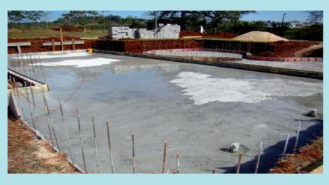
"Esse é o processo ideal para evitarmos complicações futuras", explica. E depois que a concretagem estiver totalmente seca será erguida a parede de bloco, que é a próxima fase.
