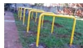
Instalação de 6 paraciclos no Bloco C-67.
